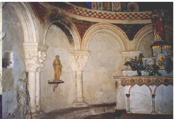
Arcature de l'abside
